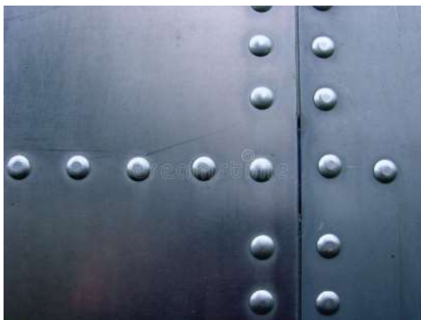
Рисунок 157 – Заклепочное соединение
